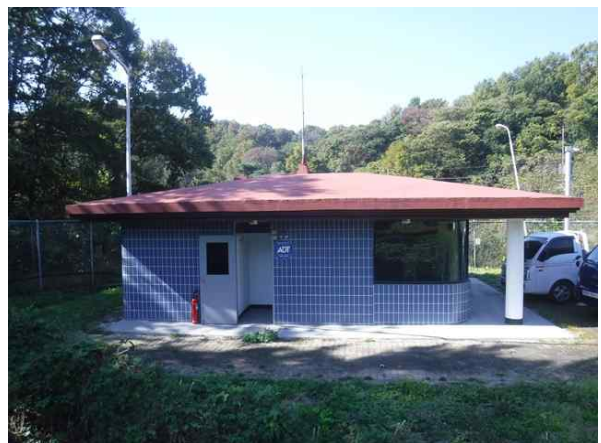
[전기실 및 관리동 외부 전경]
