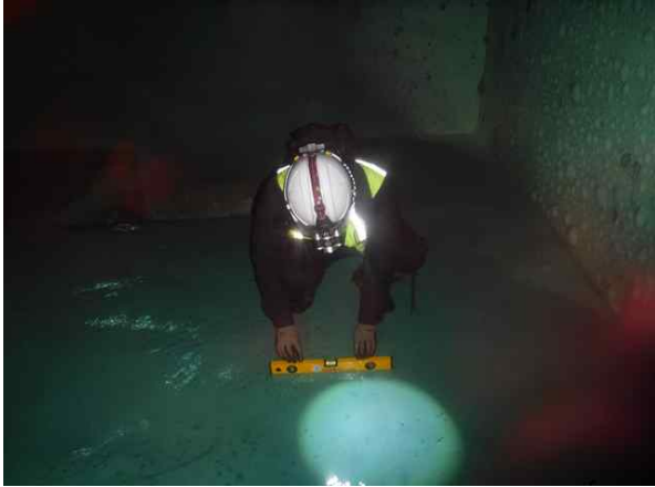
(배수지 내부 : 기울기측정 전경)
