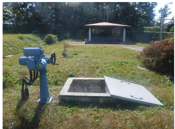
〔2호지 유출밸브실 : 점검구덮개 상태양호〕
