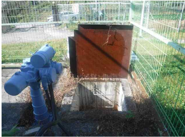
[유입밸브실 외부 전경]
