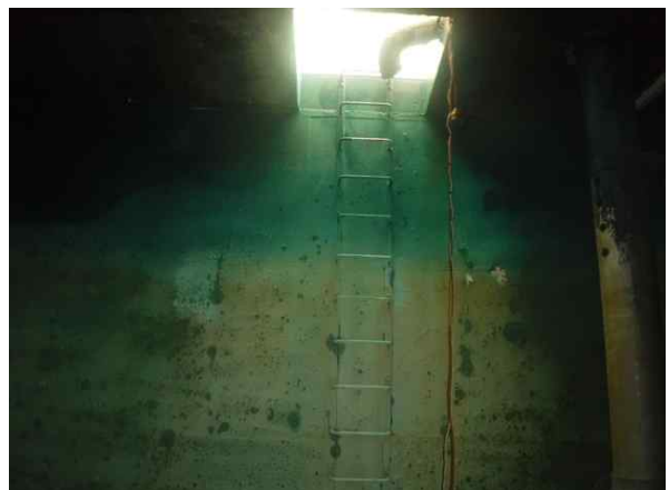
[배수지 2호지 벽체 : 사다리 상태양호]
