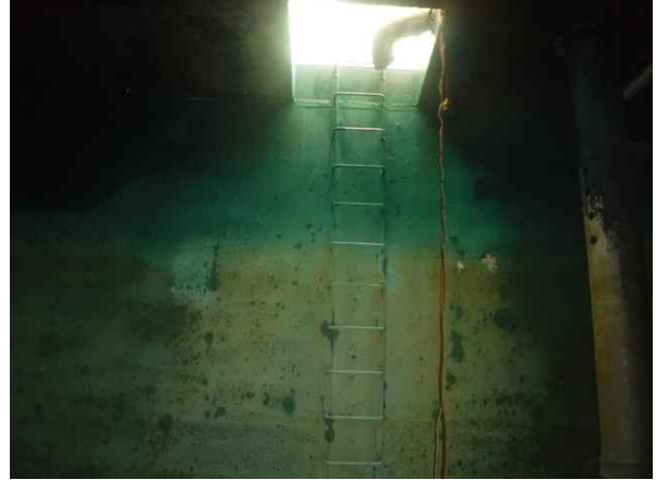
〔배수지 2호지 : 사다리 상태양호〕
