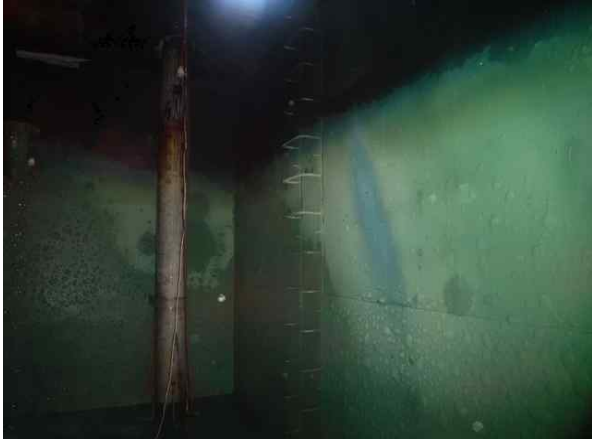
〔배수지 1호지 : 사다리 상태양호〕
