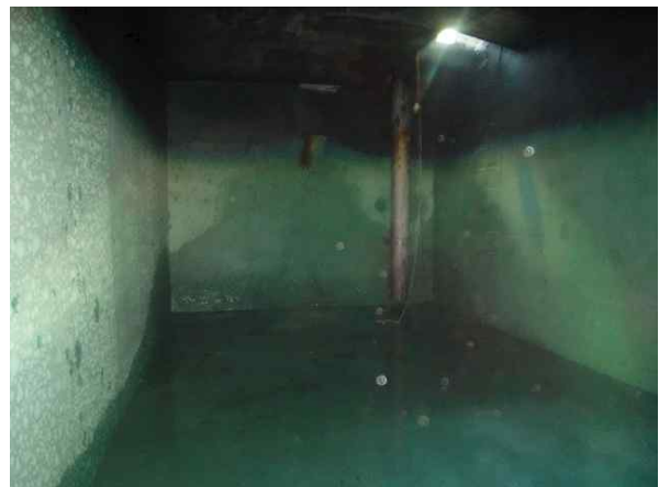
[배수지 내부 전경]
