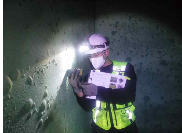
(배수지 내부 : 부재규격조사)
