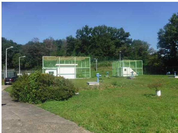
[배수지 외부 전경]
