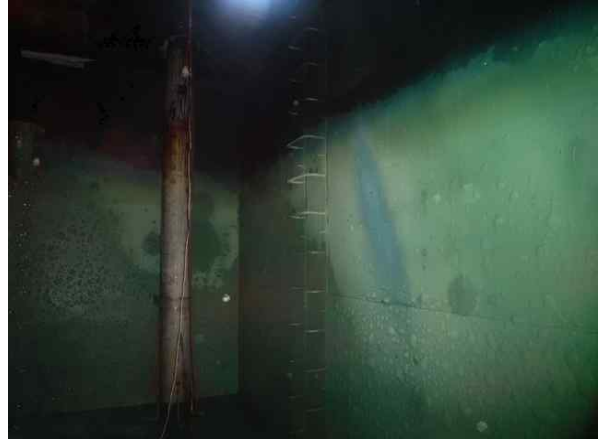
[배수지 1호지 벽체 : 사다리 상태양호]
