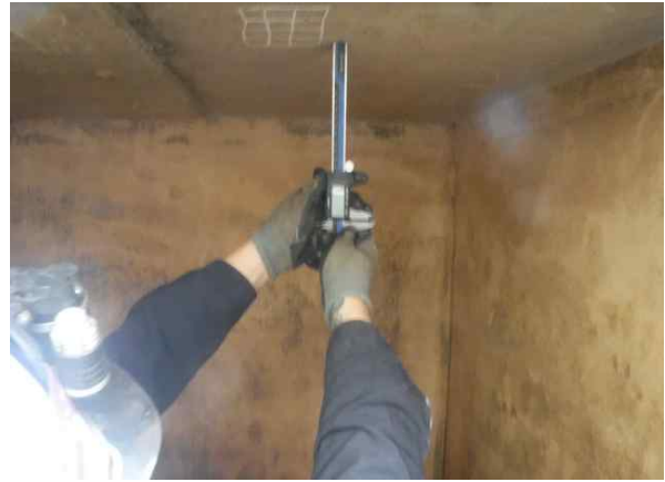
(콘크리트 탄산화 깊이 측정)
