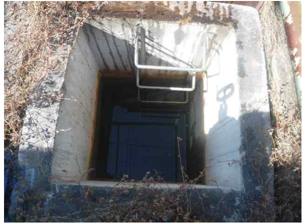
[유입밸브실 내부 전경]
