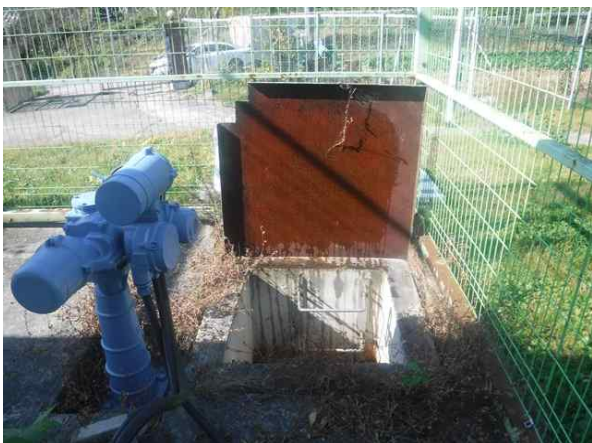
〔1호지 유입밸브실 : 점검구덮개 상태양호〕
